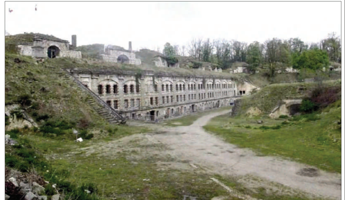
4) Vue du bâtiment casernement
