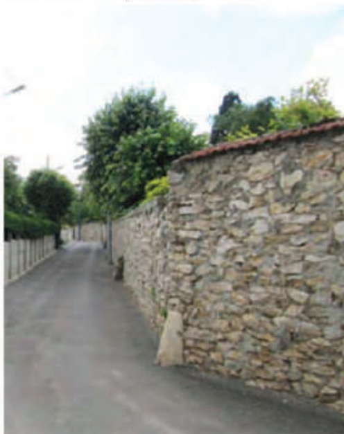
Le vocabulaire des limites parcellaires le long des chemins est un facteur de diversité paysagère essentiel (mur en pierres - chemin du Clos St Paul)
